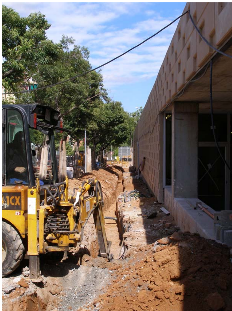
Foto 5: Excavació de la rasa a l'extrem oest.
