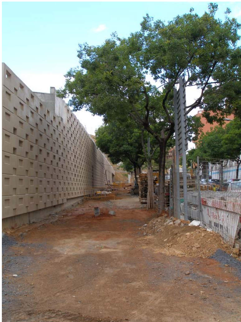
Foto 1: Zona de l'intervenció abans de l'obertura de la rasa.
