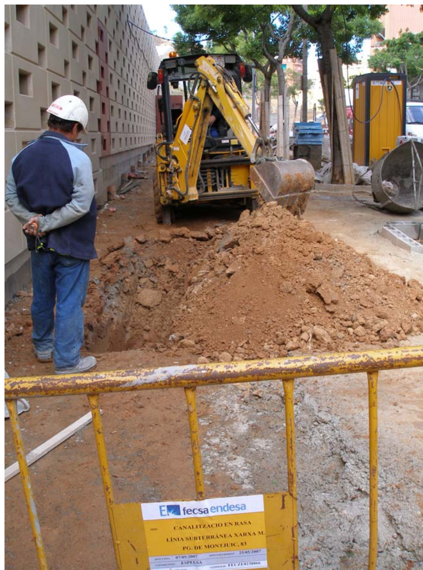
Foto 2: Excavació de la rasa amb retroexcavadora.
